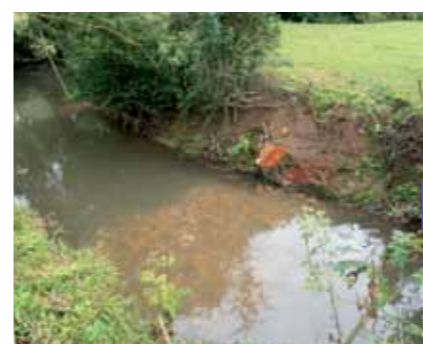
Réalisation d'un seuil de fond.
