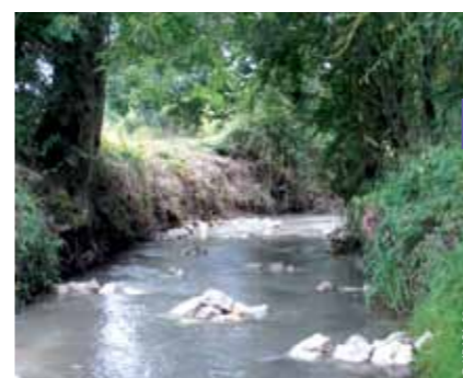
Diversification des écoulements par pose de blocs.
