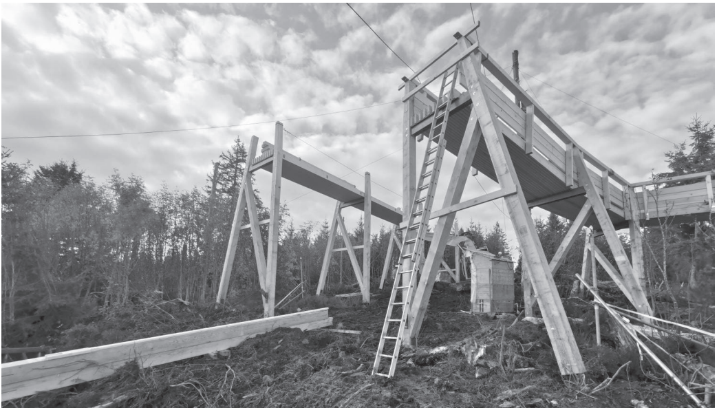
Ersatzneubau Gägersteg / Gantrisch - Beispiel für anspruchsvolle Bauten im unwegsamen Gelände mit Materialeilbahn
