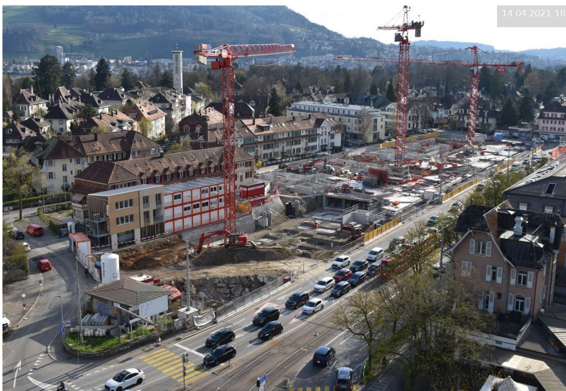
Baustelle «Läbe im Burgerziel» Stand 14.04.2021 (Foto: Webcam Losinger Marazzi)
