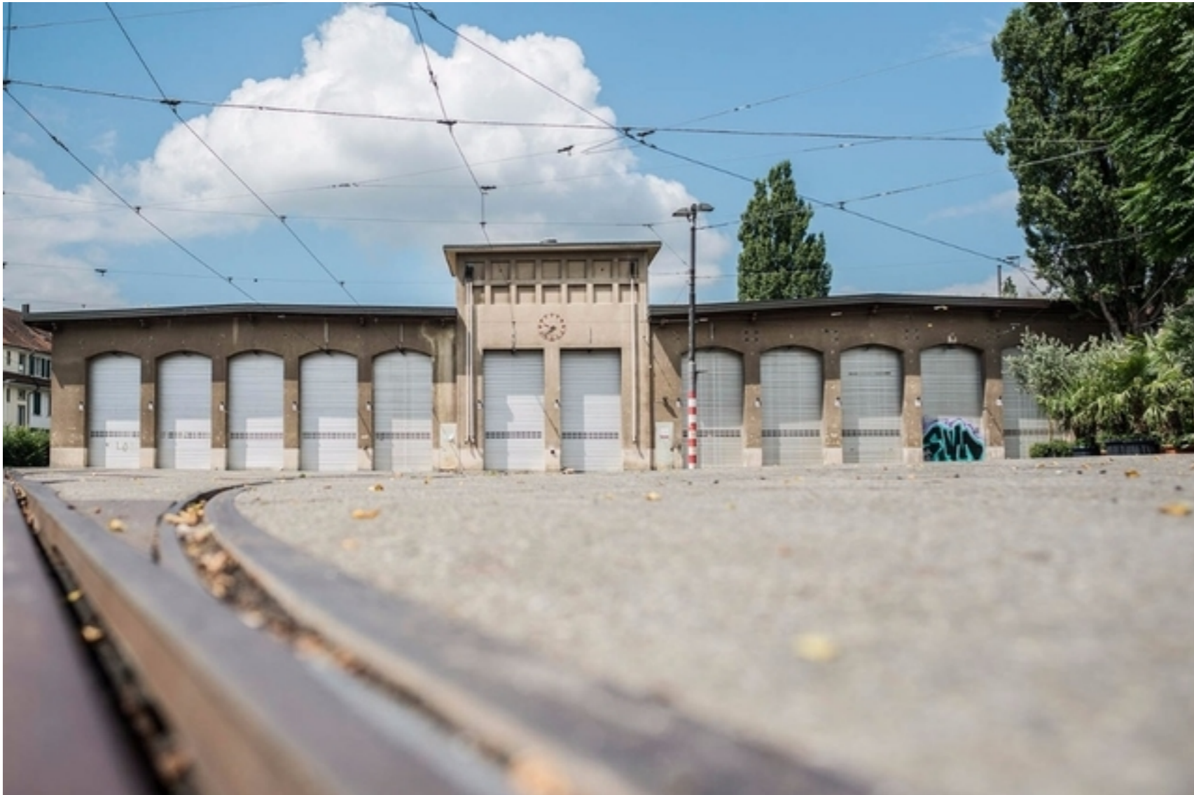
Die alte Halle des Tramdepots Burgernziel müsste weichen. Bild: Valérie Chételat
