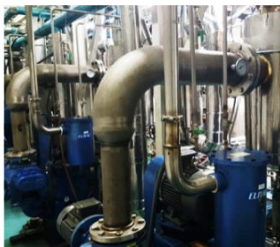
Kolbenpumpen/Roots-System in der Ölindustrie
