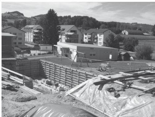
„Alte“ Kita (Pavillon im Hintergrund) und „neue“ Kita-Tagesschule Baustelle – Stand Mitte August 2019
